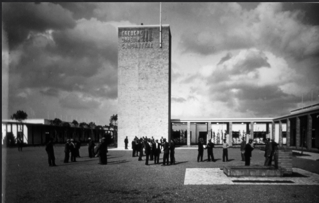
Spiazzo centrale con la torre dell'acqua (oggi qui sorgono i negozi del viale)
