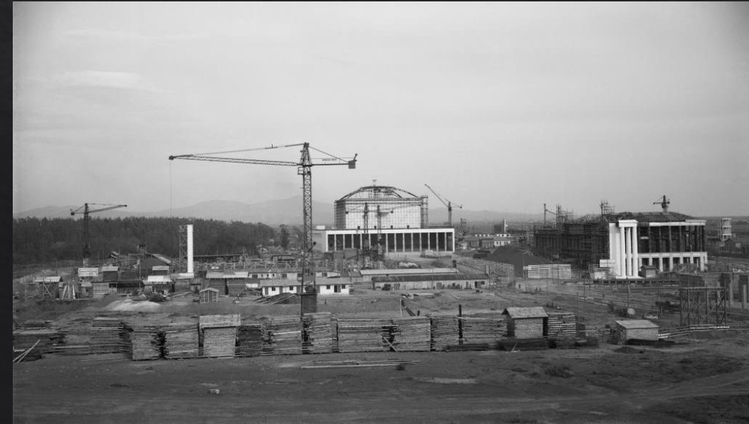
Palazzo dei Congressi in costruzione (1939)
